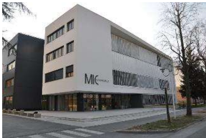
Slika 4: Novozgrajena stavba MIC, v kateri ima prostore tudi Višja strokovna šola
