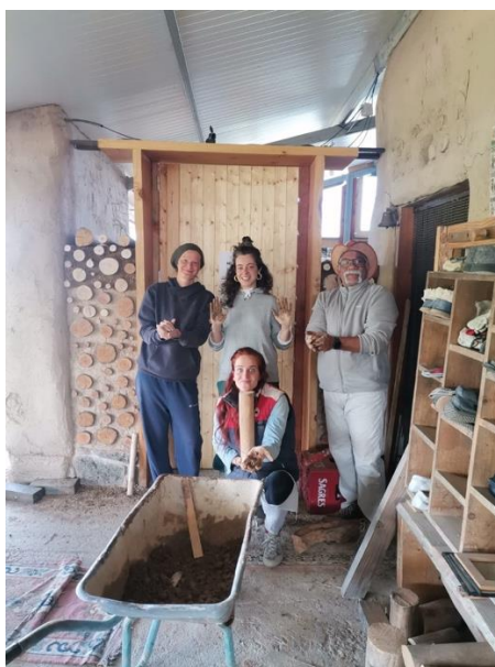
Slika 7: Delavnica naravne gradnje – udeleženci zaključujemo vhod v objekt
